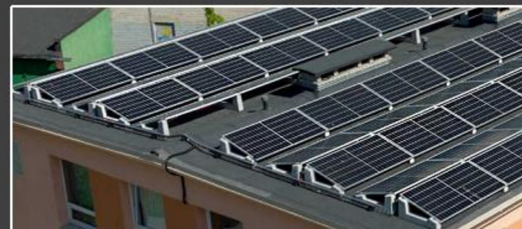
ESEMPIO INSTALLAZIONE SISTEMA EST-OVEST SU TETTO PIANO
